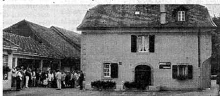
La nouvelle poste prend place au rez-de-chaussée de la Maison de commune.
