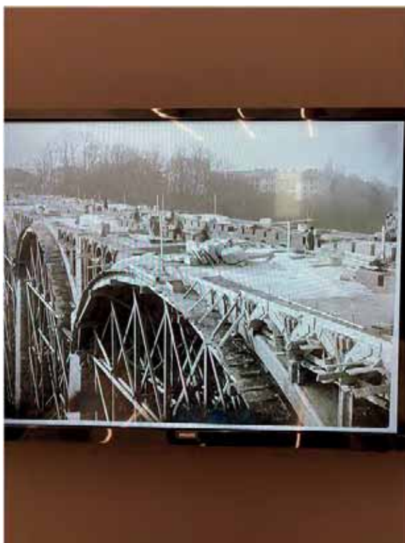
Construction du pont Chauderon
