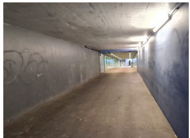
Passage sous-voies, sombre et insécurisant
