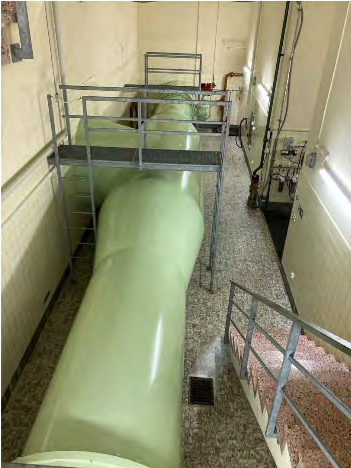
Diamètre des conduites : 1,80 m
