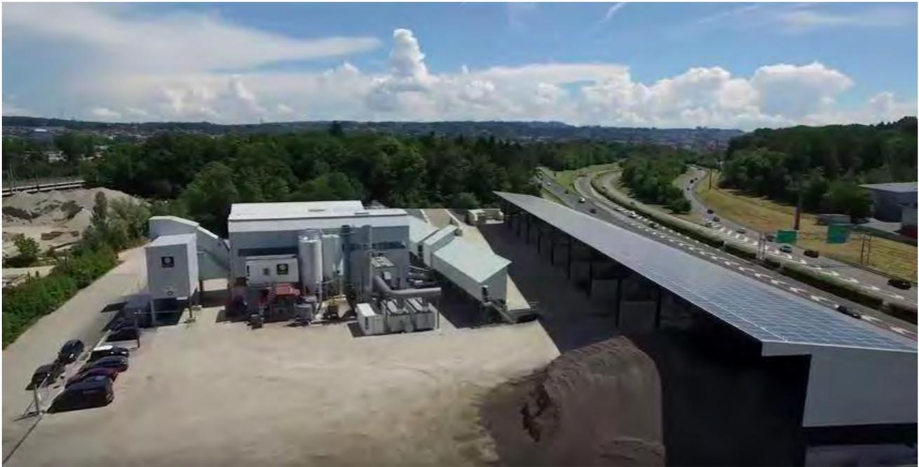
C'est la plus performante de Suisse en matière d'environnement grâce à son système de filtres à charbon actif, elle produit environ 65 000 tonnes d'enrobés bitumeux. L'énergie nécessaire est produite par une installation photovoltaïque de 3000 m<sup>2</sup>.
