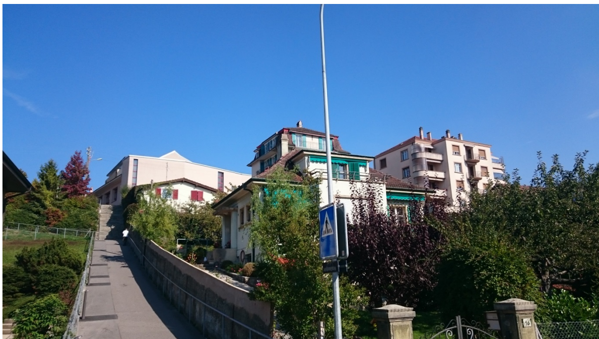
Le chemin piéton en direction du centre de Prilly
