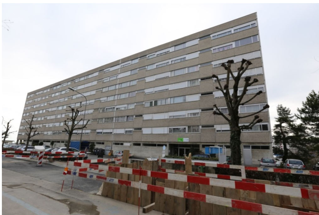
Les travaux à la Rochelle
