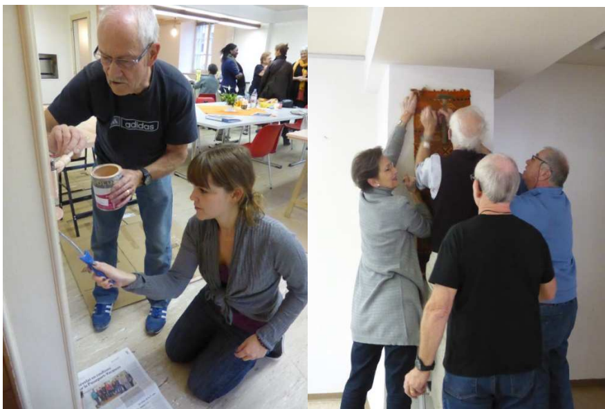
Travaux dans le local – novembre 2014
